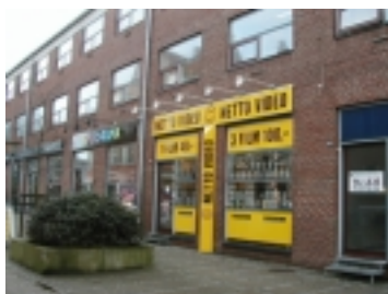
En overskiltet facade, der med den gule farve virker for dominerende på omgivelserne. Butikken er nu lukket.
