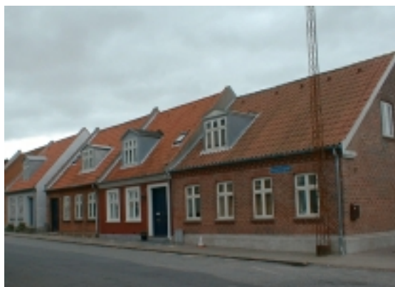
Husrække i Vesterhavsgade, der udgør en fin helhed.
