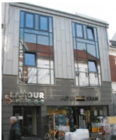
Ny facadebeklædning af granit og zink på en tidligere grim facade, Kongensgade 28.
