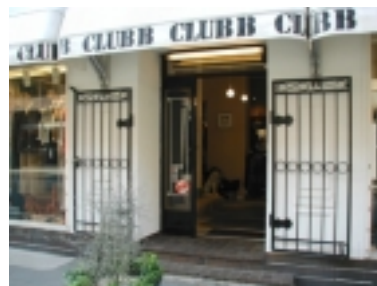
Udvendige gitterlåger til tyverisikring på Kirkegade 14.
