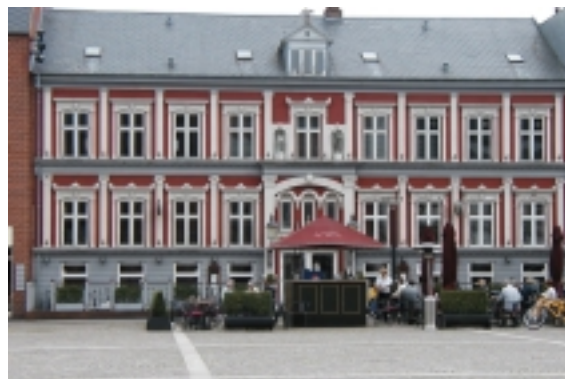
Torvet 19 før og nu fotos. Ved butikken til højre var den oprindelige facade fjernet. Den er nu genopbygget og de store skilte er fjernet.
